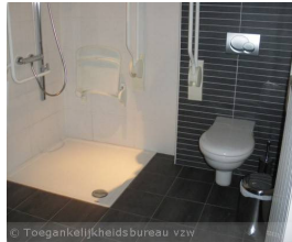
inloopdouche gebruikt als opstelruimte, bron: Toegankelijkheidsbureau
